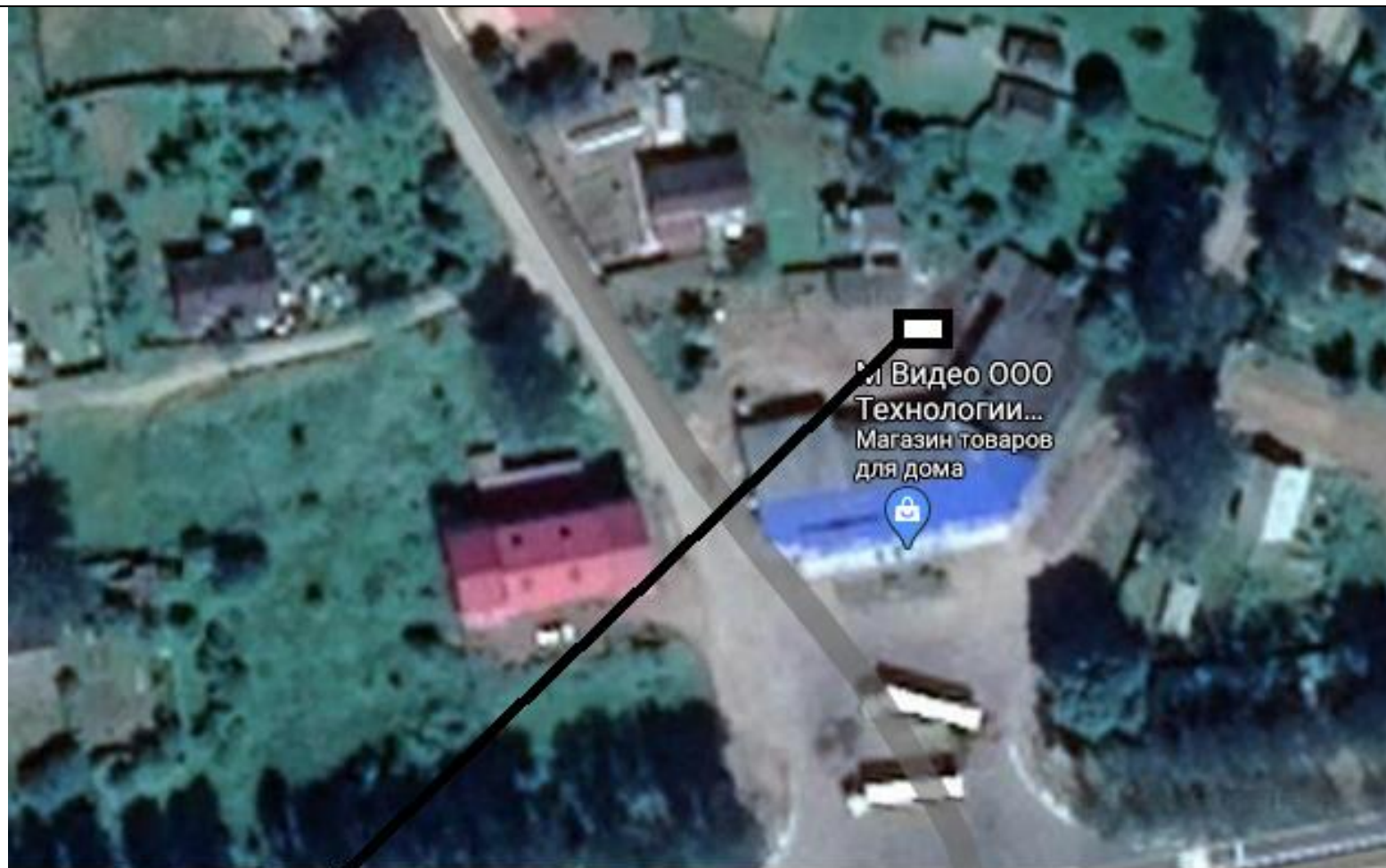
Место размещения площадки ТКО
